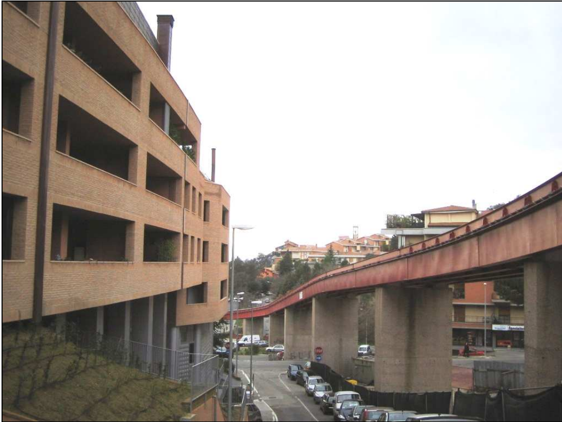
Figura 6: facciata dell'edificio di Via R. d'Andreotto 12 esposta verso l'impianto del Minimetrom
