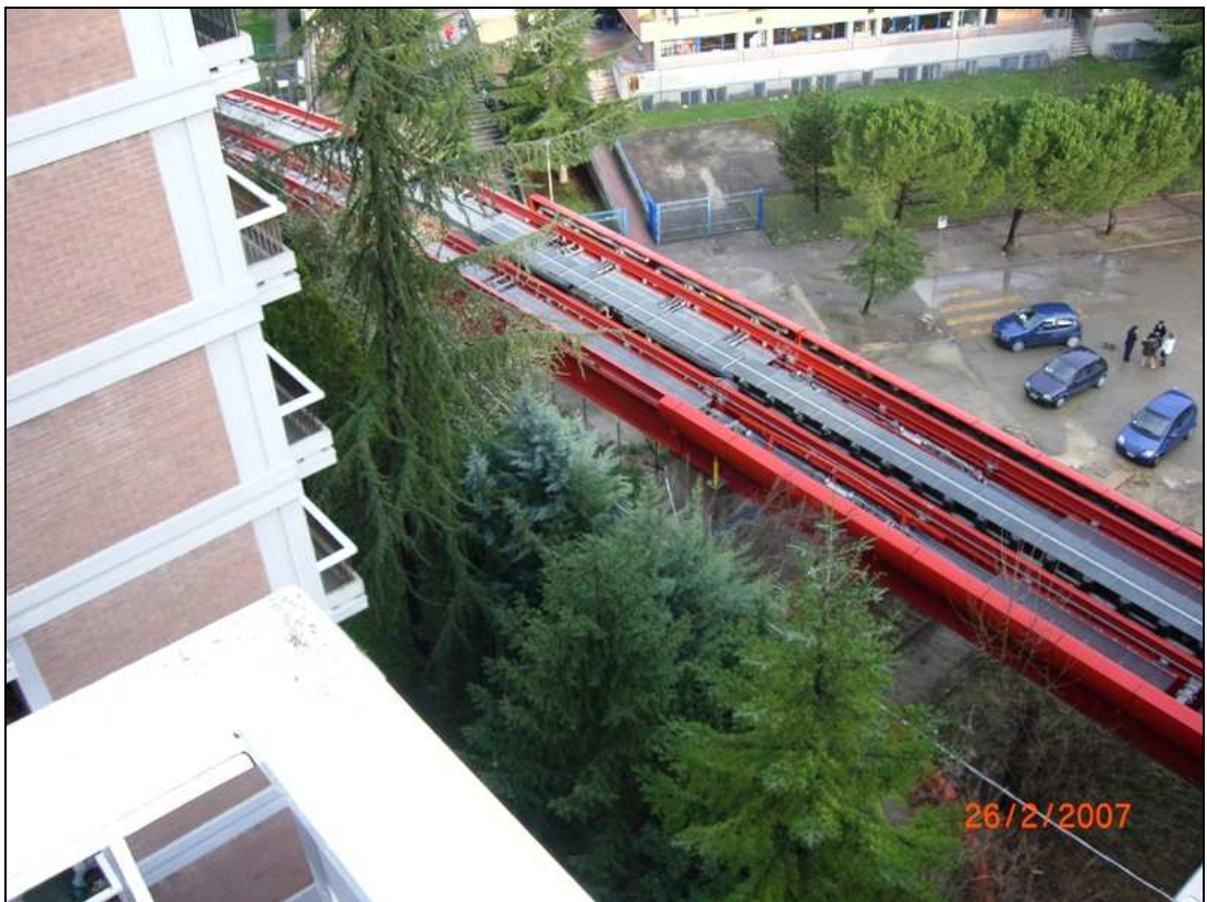
Figura 7: Vista dell'impianto del Minimetrom dal punto di misura presso l'edificio di Via Morgagni 1
