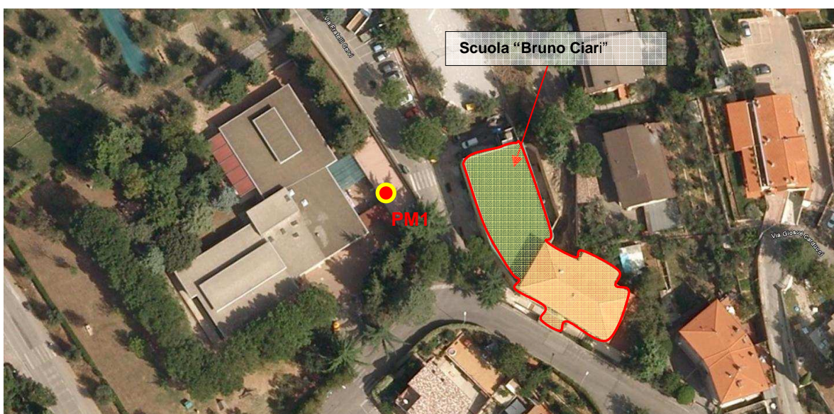
Fotografia 7: Vista aerea del luogo dove è stata installata la postazione fonometrica per il monitoraggio acustico in ambiente esterno.
