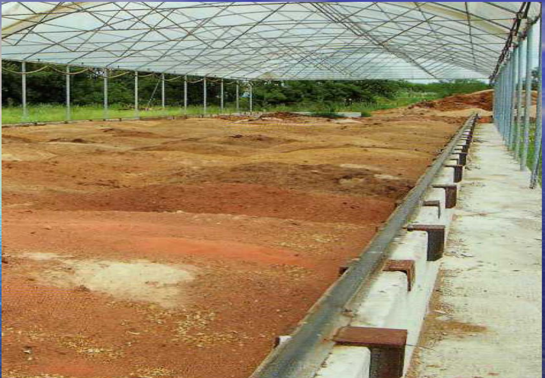
Foto F.29 Materiale lignocellulosico su cui vengono distribuiti i liquami
