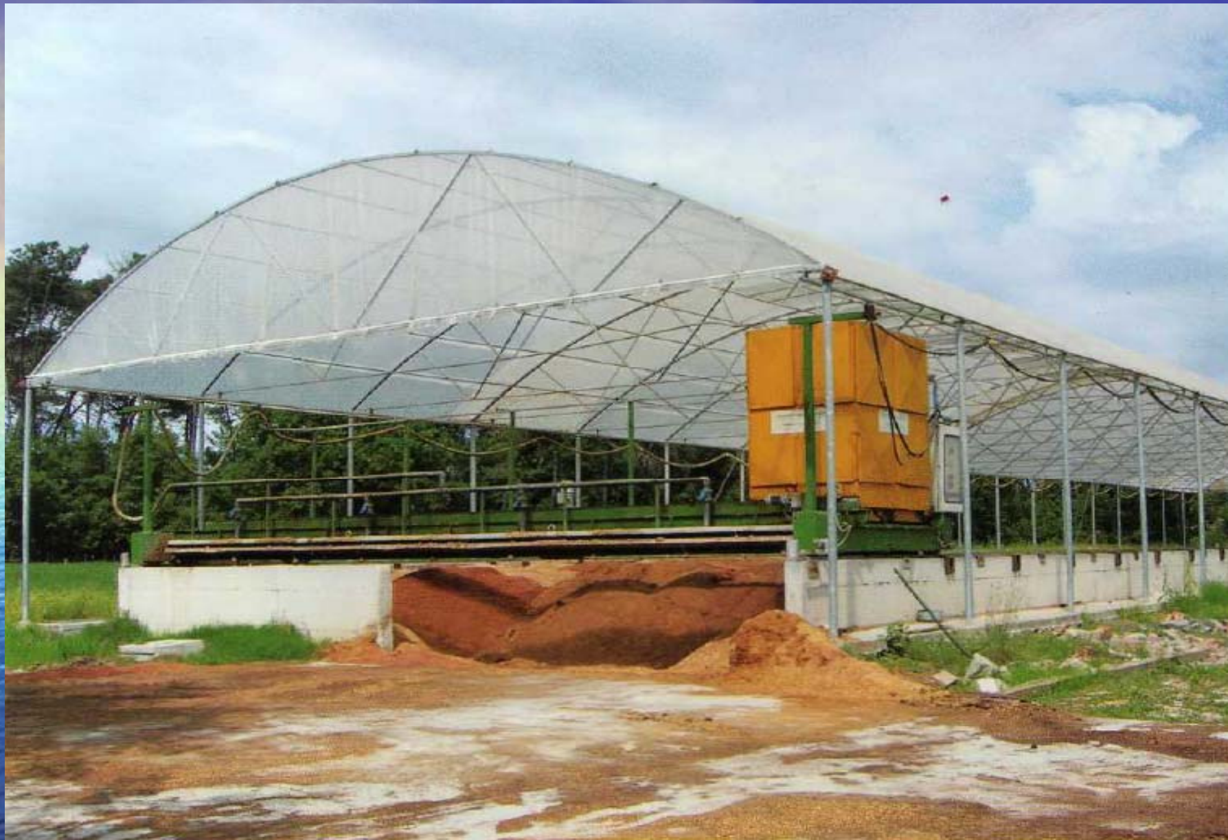
Fig. 27 Moderno impianto di compostaggio dei reflui suinicoli in loc. "I Castagni", Castiglione del Lago
