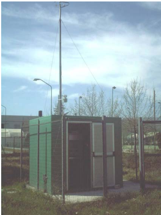
Fig.3.Cabina di monitoraggio Postazione B
