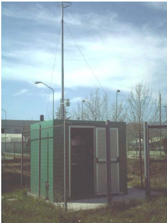
Fig.3.Cabina di monitoraggio Postazione B
