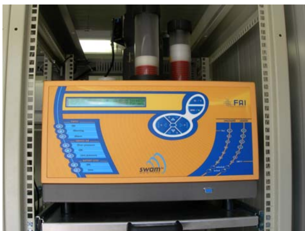
Fig 3 : Analizzatori in continuo installati
