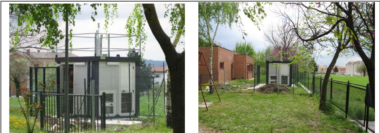
Fig.6 - Postazione di Monitoraggio di Via Leonardo da Vinci
