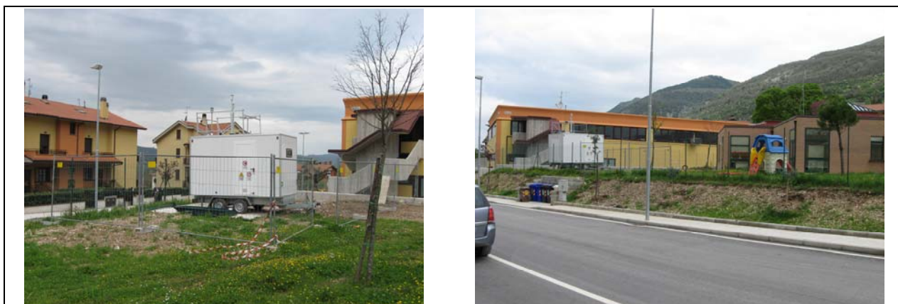
Fig.2 – Mezzo Mobile nella postazione di Monitoraggio di Semonte
