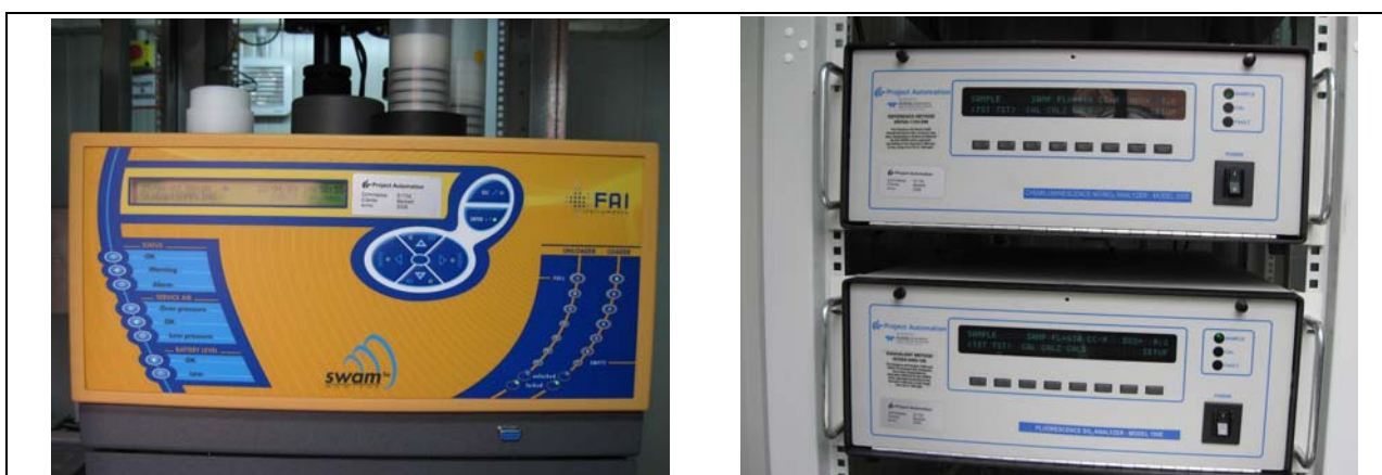
Fig.5: Analizzatori in continuo
