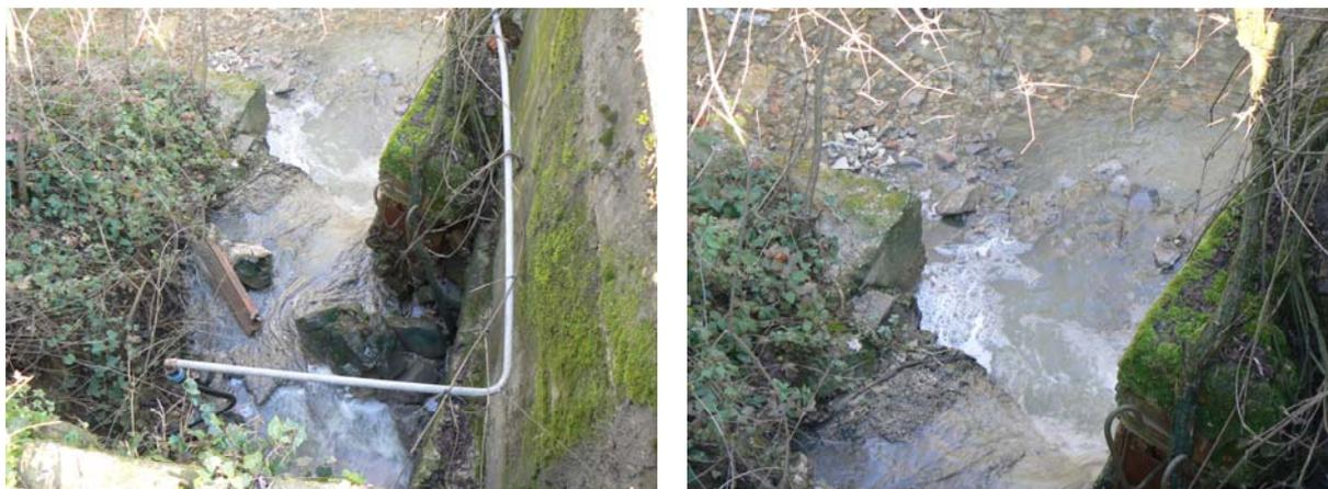
**Fig. 3.2.2.9** - Scarico di by-pass della rete fognaria di Marsciano nel fosso delle Fornaci
