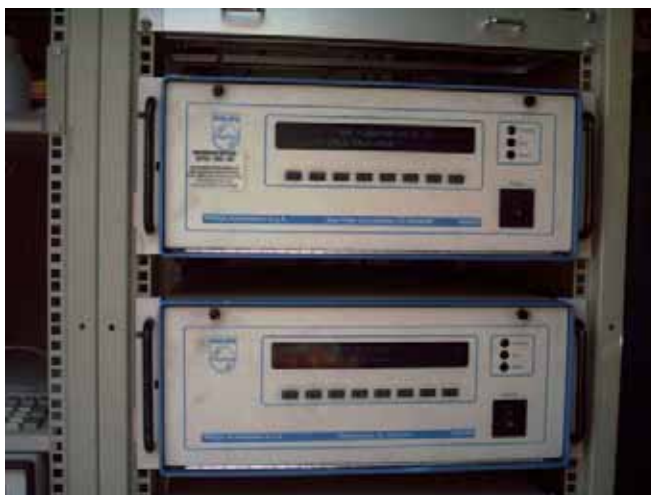
Fig 5 - Analizzatori automatici in continuo
