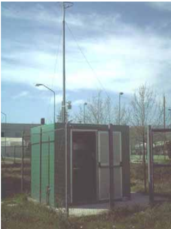
Fig.3.Cabina di monitoraggio per analisi PM10, NOx, CO e O3 – Postazione B
