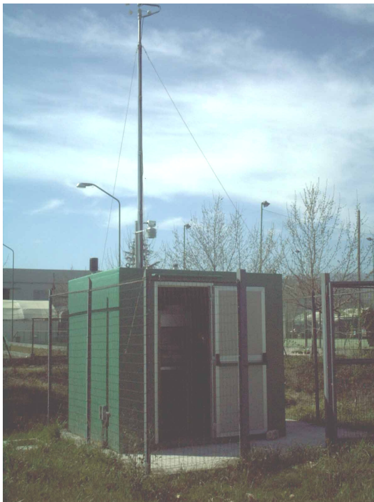
Cabina di monitoraggio per analisi NOx, CO e O3 – Postazione B
