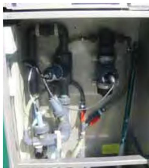
**Figura 10.4** - Sistema di prelievo forzato delle acque del canale
