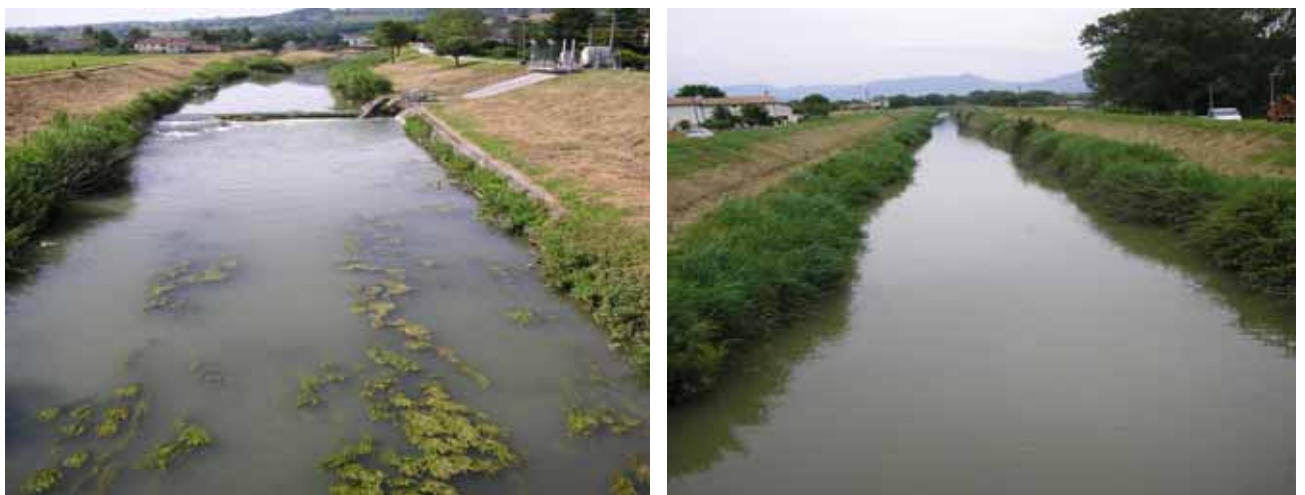
Fig. 3.4.2.5 – Torrente Timia: artificializzazione del corso d’acqua.
