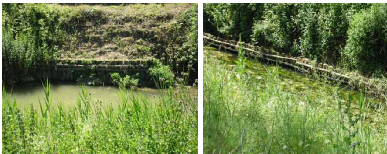
Fig. 3.4.2.17 – Consolidamento della sponda sinistra del torrente Teverone con palizzate.
