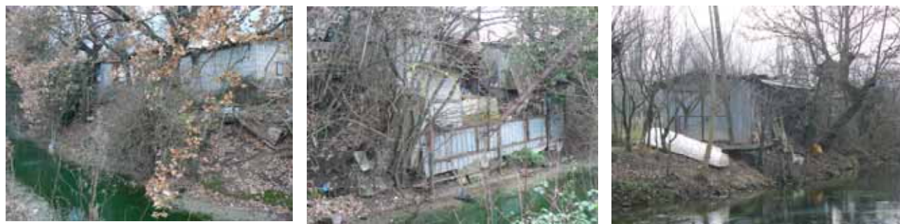
Fig. 5.1.1 – Esempi di strutture realizzate a ridosso del fiume Clitunno .
