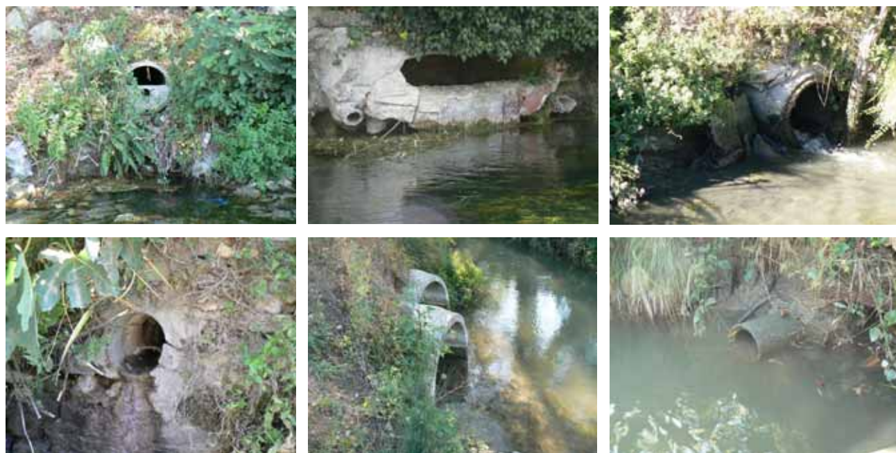
Fig. 2.2.2.1 – Esempi di scarichi rilevati nel corso principale del Clitunno (SC10-Località Pissignano, SC18-Località Chiesa Tonda, SC62/SC65-Località Casco dell'Acqua, SC75-Torre di Montefalco, SC85-Bevagna).
