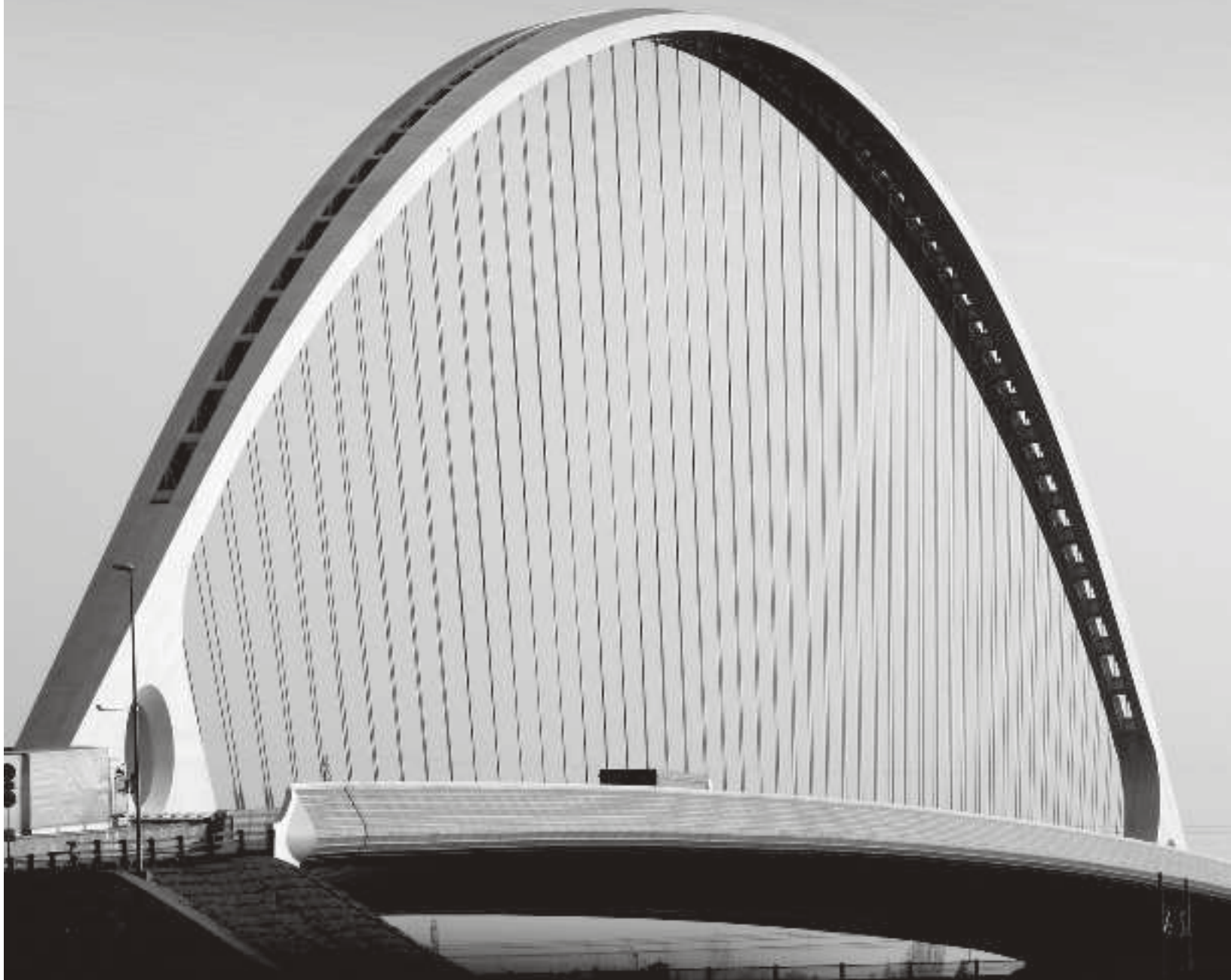
Santiago Calatrava - Ponte strallato / Reggio Emilia (Italia) 2007
