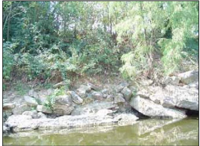
**Fig.48. Difesa spondale in massi per stabilizzare la riva e attenuare la forza erosiva della corrente.**
