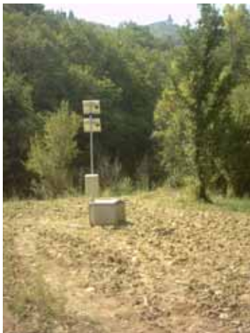
Figura 2 – Stazione piezometrica Valle del Tescio.
