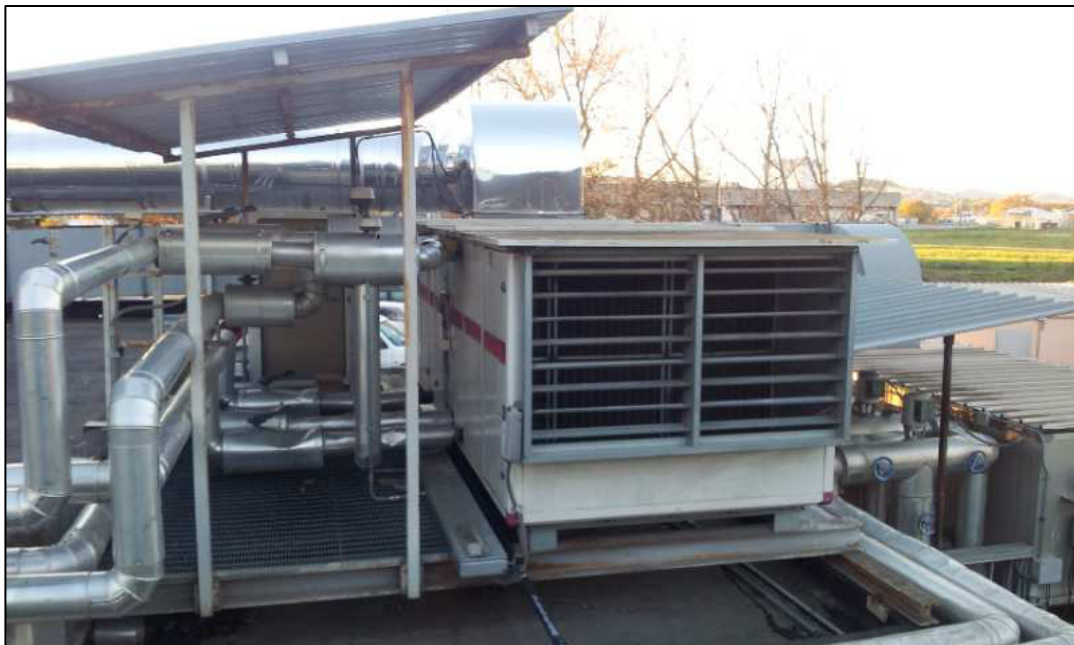
Fig. 1 - UTA a servizio piano 1° (laboratori)
