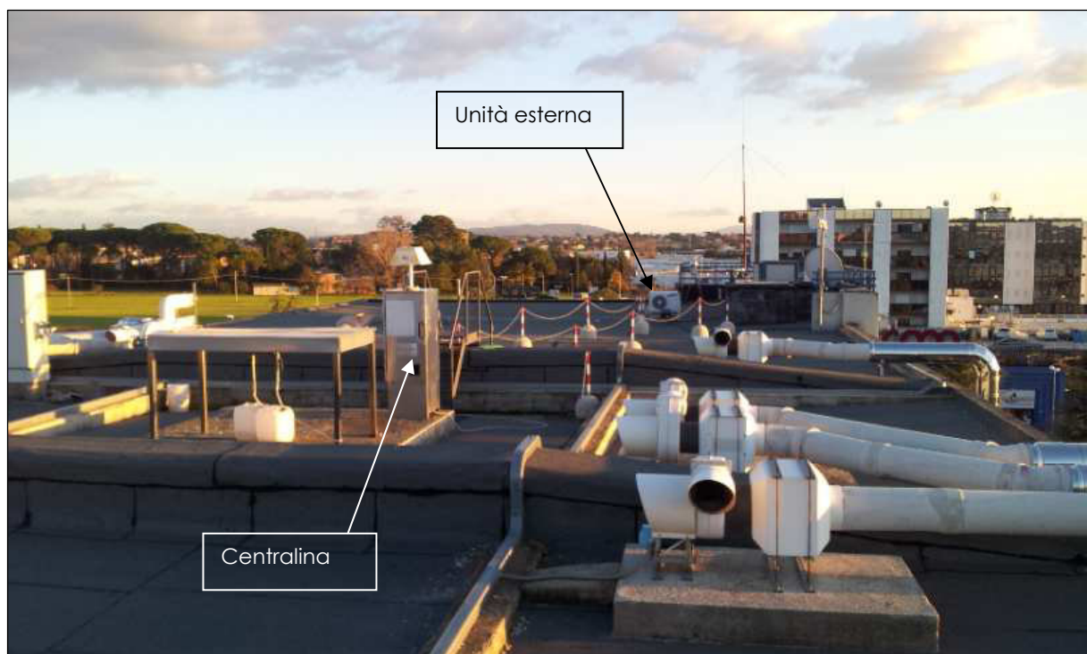
Fig.9 – Centralina e unità esterna impianto
