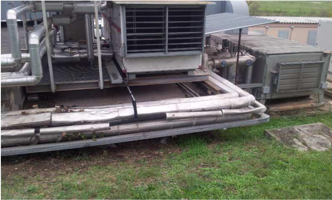
Fig. 5 – Tubazioni con isolamento da ripristinare
