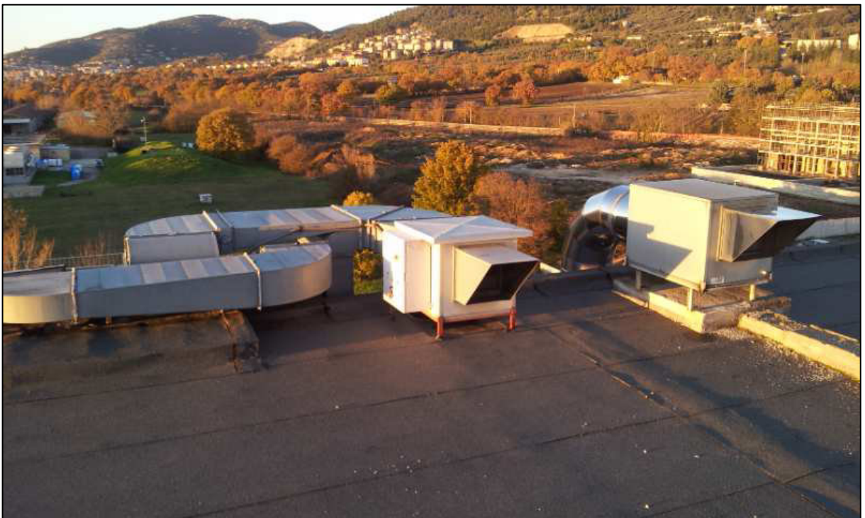
Fig. 3 – Estrattori in copertura per ripresa impianto aria primaria
