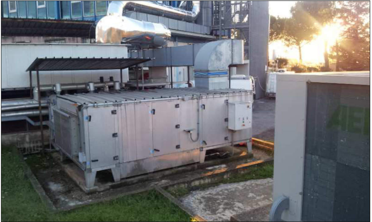
Fig. 2 - UTA a servizio piano seminterrato, terra, 2° e 3°
