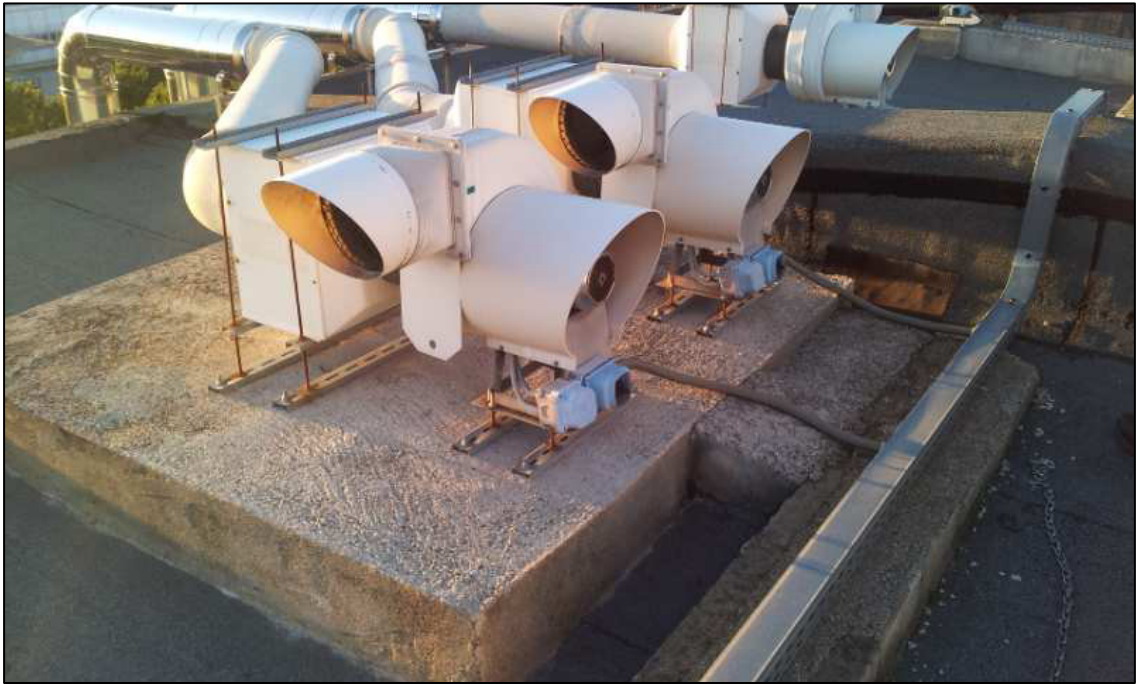
Fig. 4 – Estrattori aria cappe laboratori posizionati in copertura
