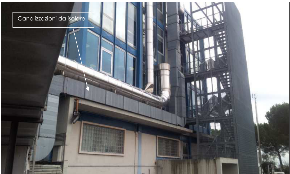
Fig.8 – Canalizzazioni aria primaria da isolare
