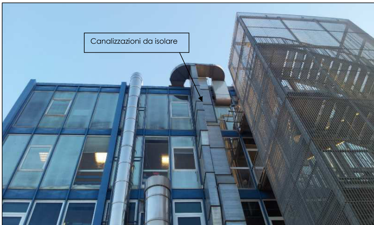
Fig.6 – Canalizzazioni aria primaria da isolare
