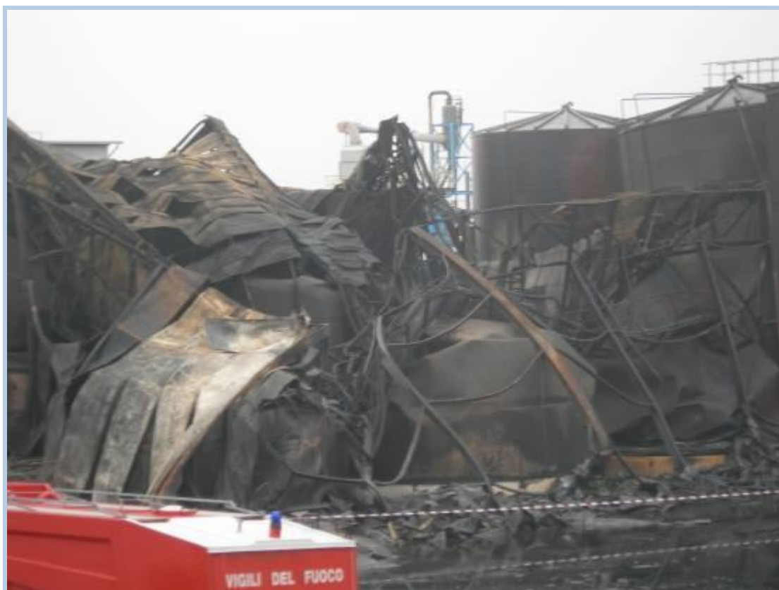
Figura 5: Serbatoi esplosi.
